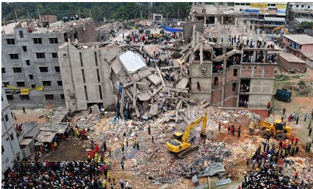
Figura 2: Colapso Rana Plaza, em Bangladesh, 2013.
