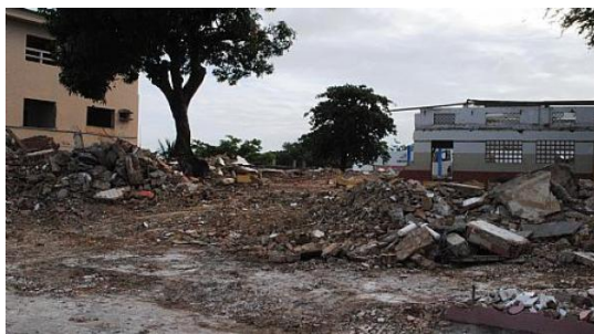
Figura 8: Demolição do Colégio Batista em 2013. Fonte: ALAGOAS 24 HORAS, 2013.
