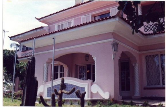
Figura 2: Telhado em várias águas e telhado com acabamento em peito de pombo.
