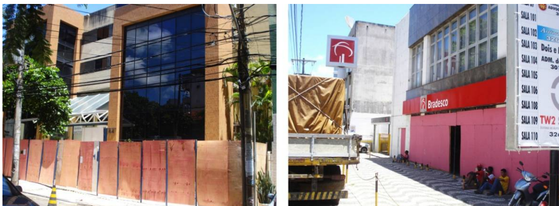
FIGURAS 8 e 9 – Tapumes de madeira colocados nas fachadas. FONTE - Fotografias produzidas pelo PETCOM.
