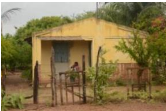
Fachada da casa
