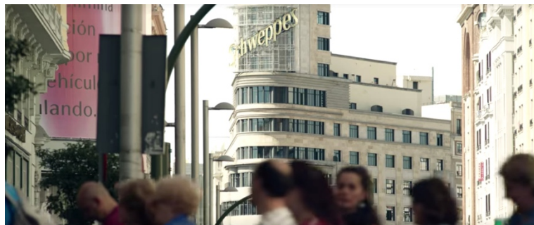
Figura 4 – Plano geral do Edifício Carrión. Fonte: DVD película Que Dios nos perdone .
