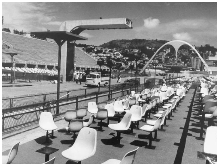
Figura – Construção da Passarela do Samba
