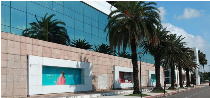
Figura 13 – Placas da fachada do Shopping Vitória (parte central)
