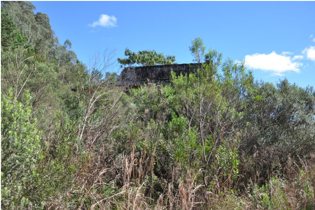
Figura 2 – Imagem tomada em 2019: Estação Ferroviária abandonada
