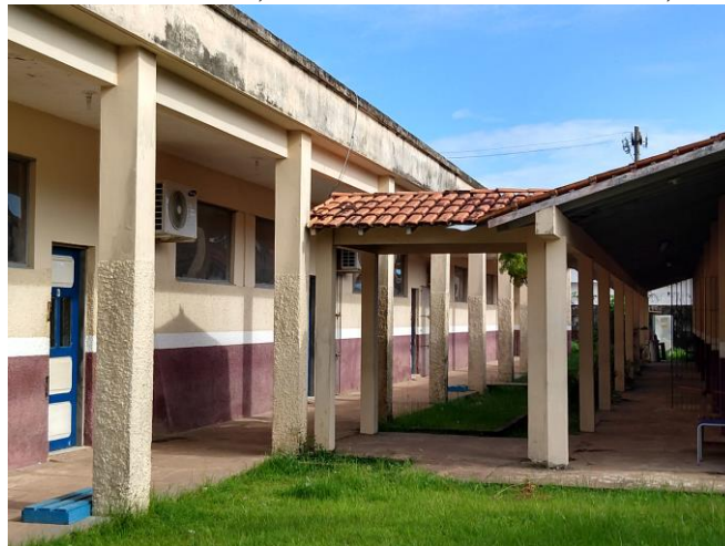
Figura 3 – Vista parcial da Escola Estadual de Ensino Fundamental e Médio João XXIII, São Sebastião da Boa Vista, Pará, agosto de 2018.
