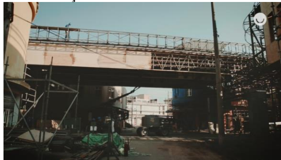
Figura 13 - Construção do viaduto nos estúdios MG4
