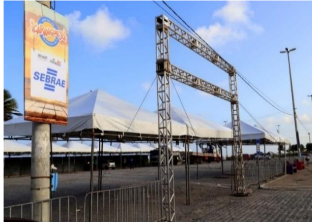
Figura 1 - Arena gastronômica em processo de montagem
