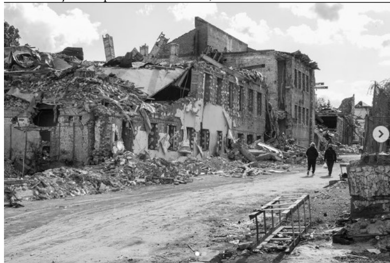
Figura 2 – Destruição dos prédios em Kharkiv, Ucrânia. Foto de Gabriel Chaim.
