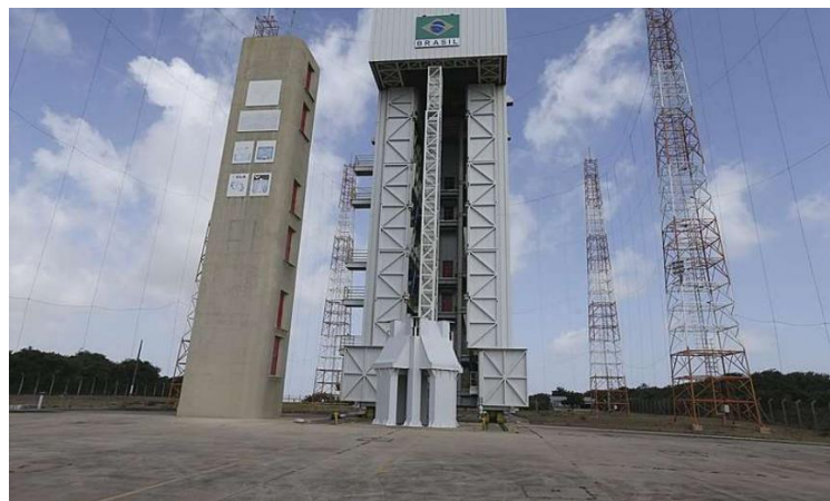
Figura 04 – Vista da estrutura da plataforma de lançamento
