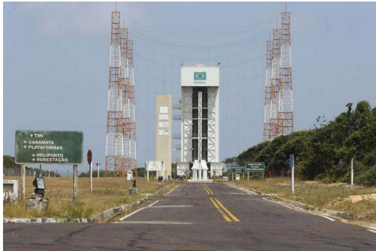
Figura 02 – Estrutura da plataforma de lançamento vista da estrada de acesso
