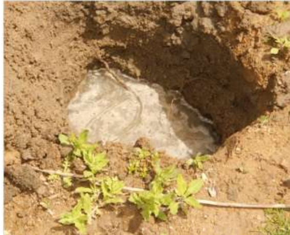
Figura 1 – Escavação para fazer caçimba
