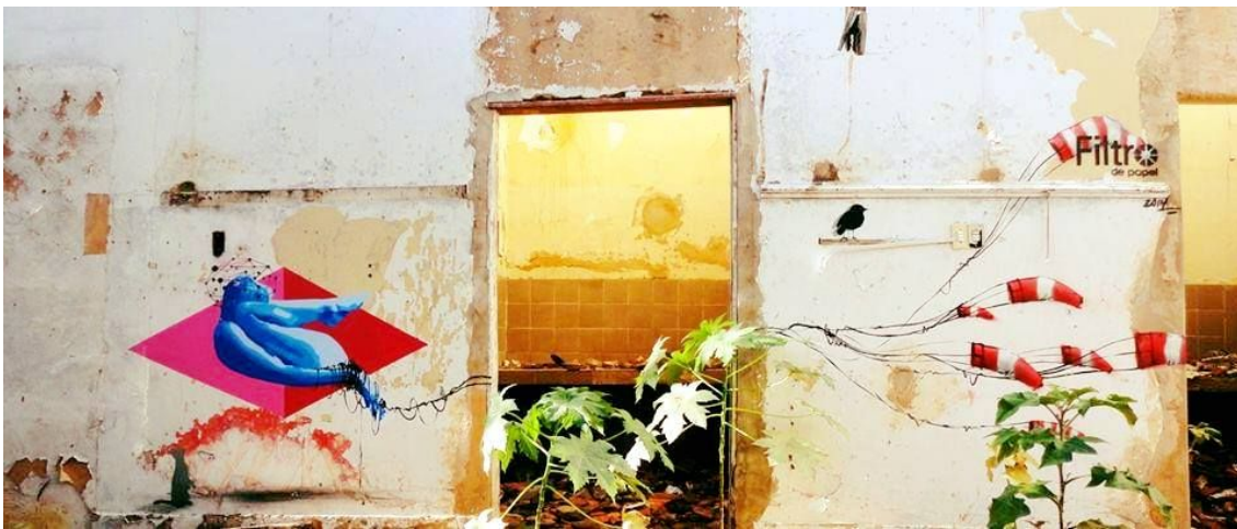
Figura 1 - Espaço em demolição na imediações da Av. Aguamanbi, setembro de 2015
