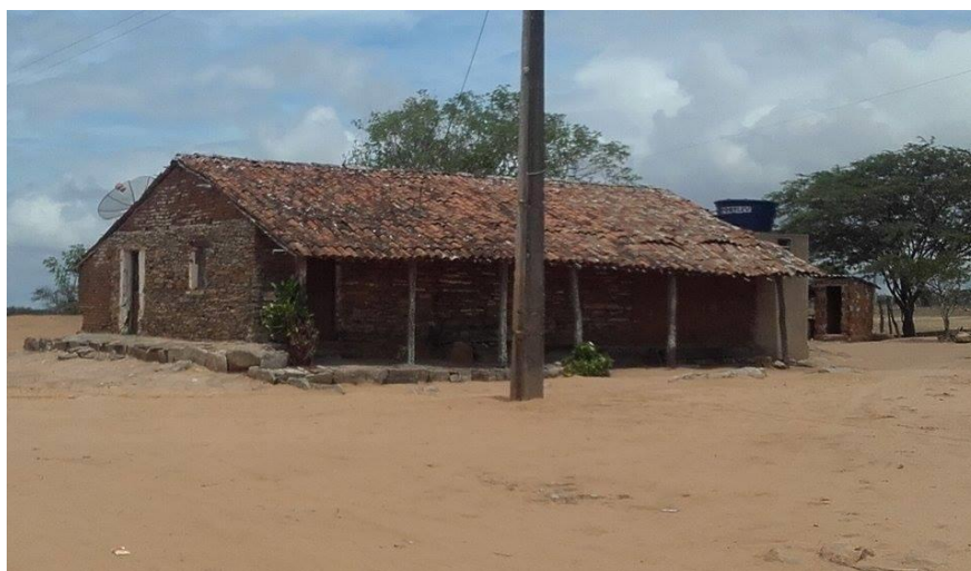
FIGURA 05 – Casa de Pedra
