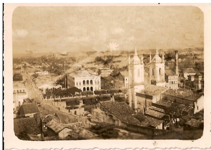
Fig.01 - Praça dos Martírios, Centro de Maceió
