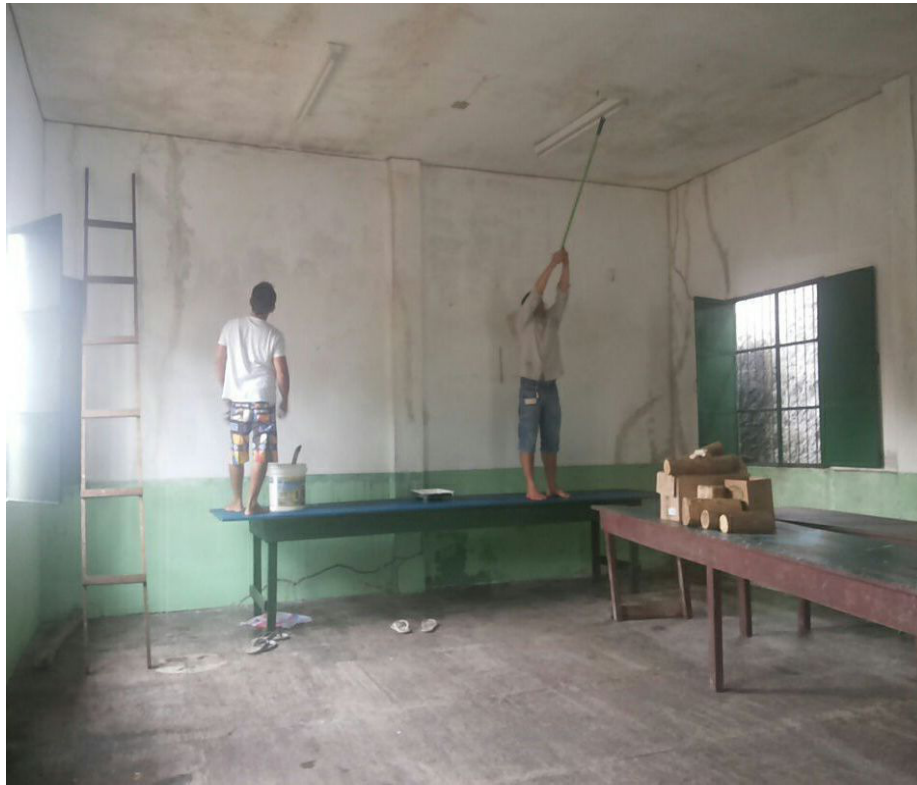
Figura 2: Realização da pintura do ambiente
