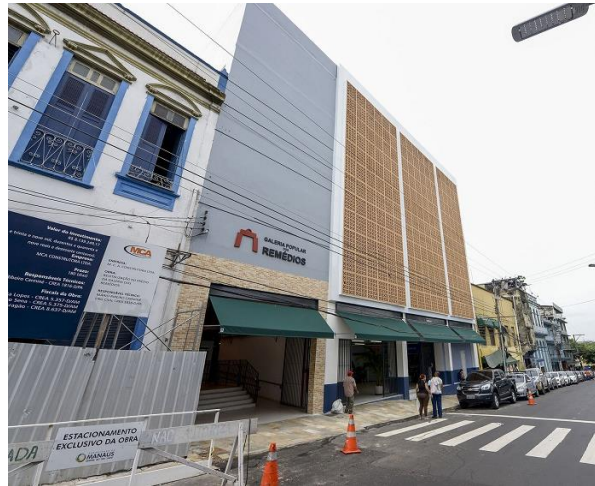
Figura 1: Galeria dos Remédios.
