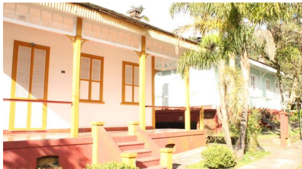
Figura 1 – Casa de engenheiro em Paranapiacaba.
