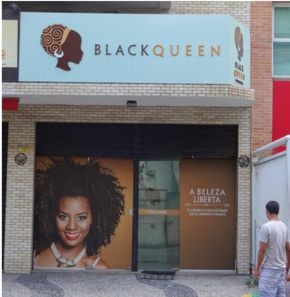
Figura 6 – Fachada do salão Black Queen
