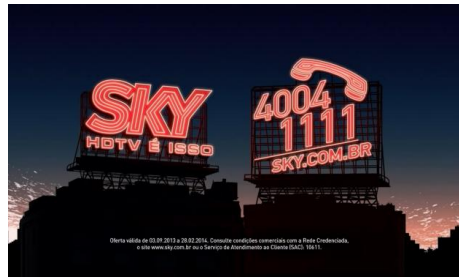
Figura 10 – Plano geral do Edifício Sky à noite. Fonte: Imagem retirada da publicidade disponível no Youtube.
